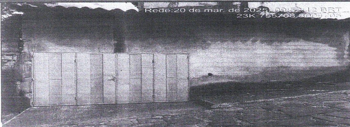
VISTA DA FACHADA PRINCIPAL
